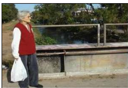
Foto 13 – Vila Minuano: esgoto
