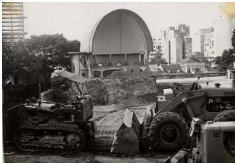
Figura 7 – Obras de demolição do Auditório Araújo Vianna em 1958
