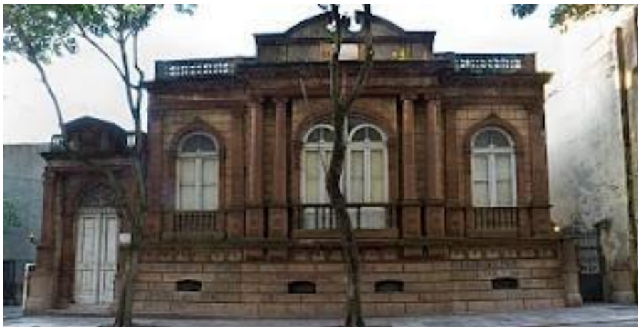
Figura 1 – Fachada original do Museu Júlio De Castilhos
