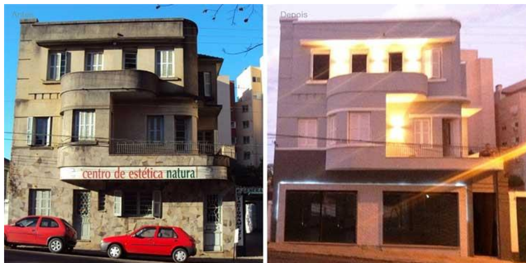
Figura 1 – Exemplo de antes e depois do retrofit
