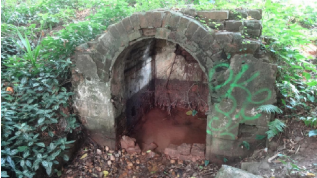
Figura 2 – Fonte Dona Josefina, no estado de conservação atual.
