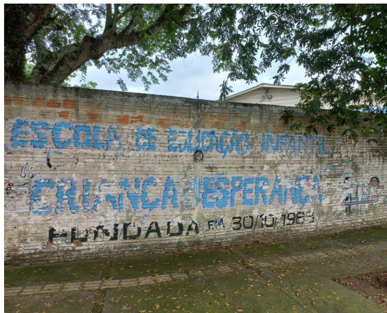
Figura 3 - Muro externo da escola
