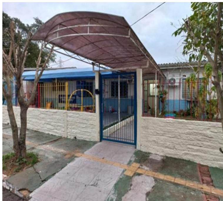
Figura 12 - Fachada da entrada principal
