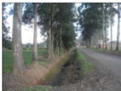
Foto 3.1.1 – Vala de drenagem verificada na área, conduz o escoamento em direção ao canal de drenagem do DEP.
