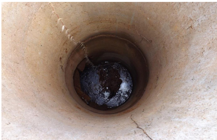
Figura 16 - Ponto de interligação com a rede de esgoto da cidade.
