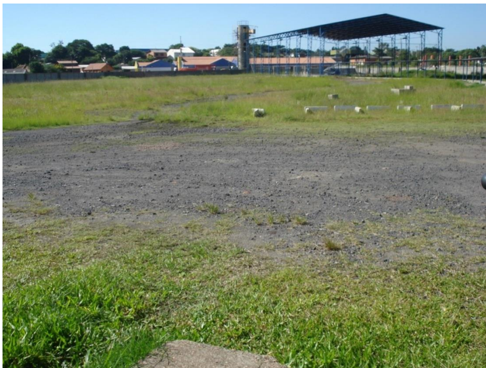
Figura 9 - Parte da área antes da reabilitação.
