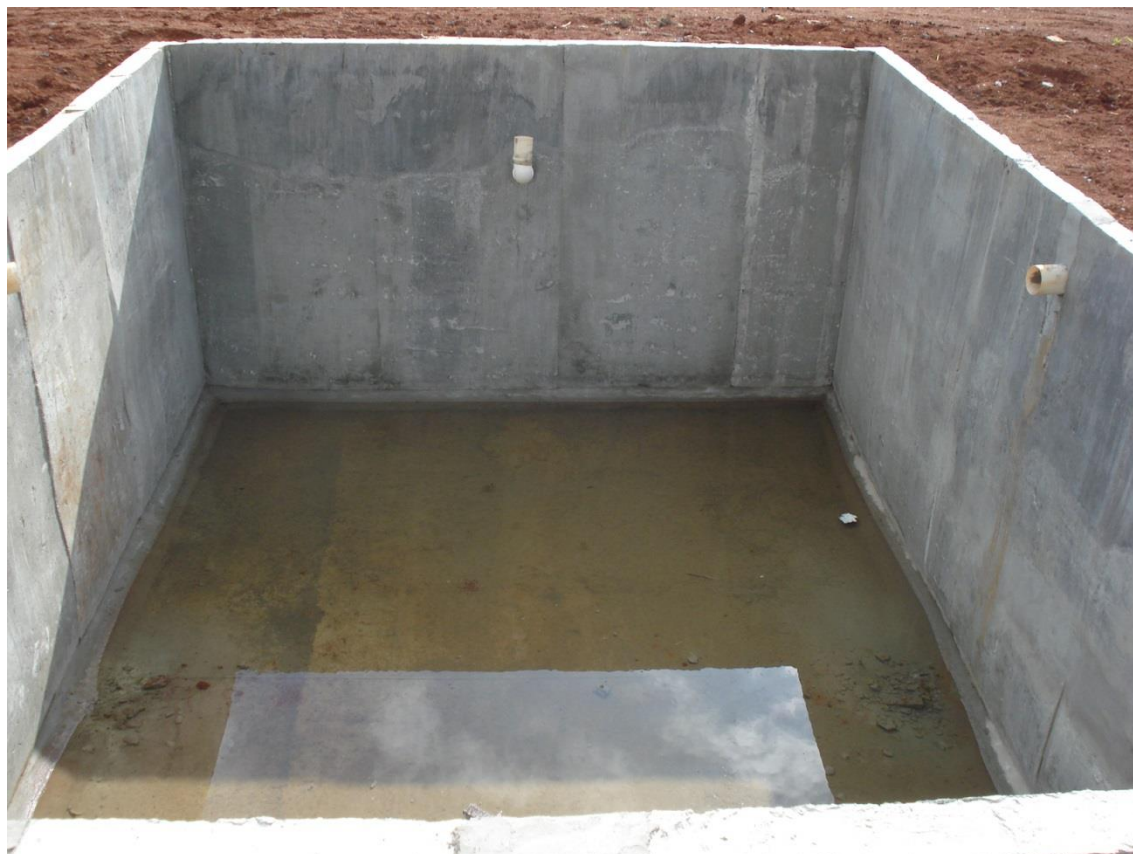
Figura 26 - Cisterna concluída com água de origem subterrânea.
