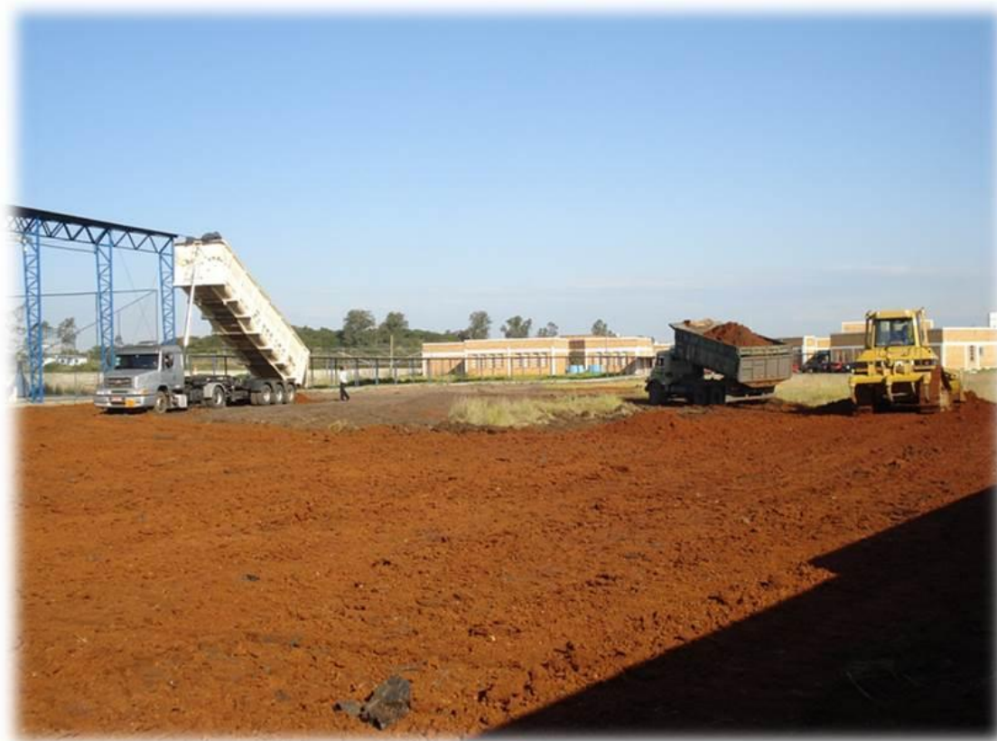
Figura 11 - Máquinas e caminhões durante a recuperação.
