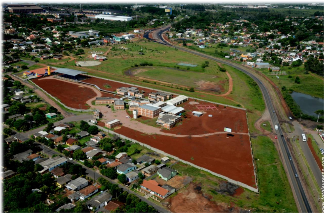
Figura 14 - Vista aérea do Câmpus após a reabilitação
