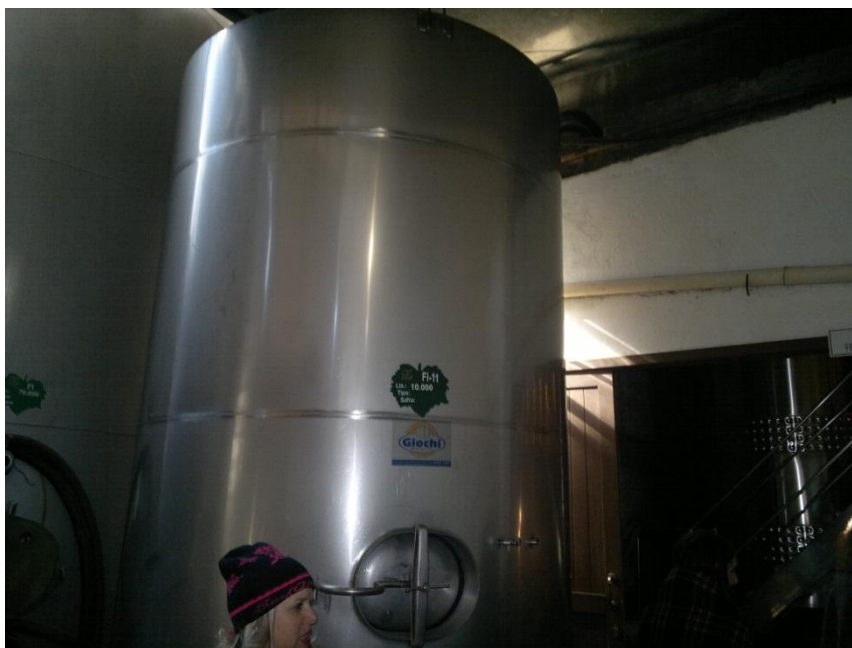
Imagem 8 – Tanque de aço inoxidável
