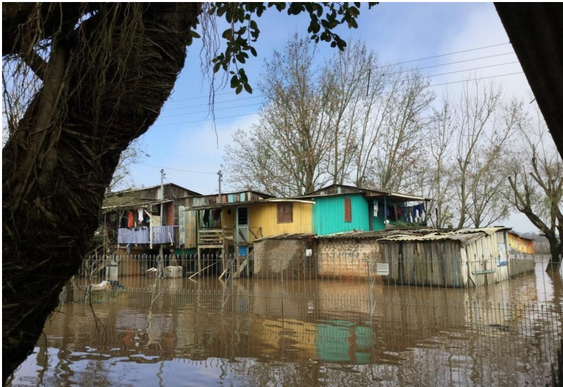
Figura 15 – Rua tomada pela enchente
