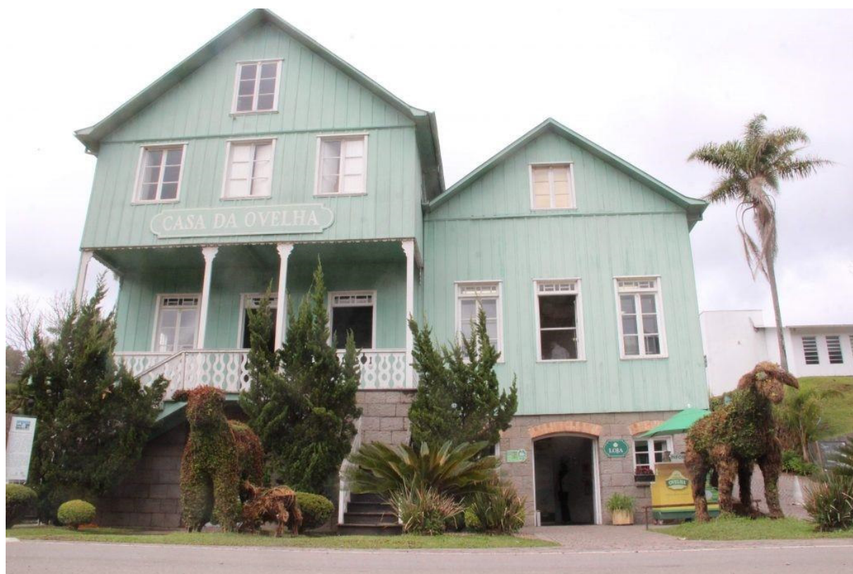
Figura 4 - Parque da Ovelha
