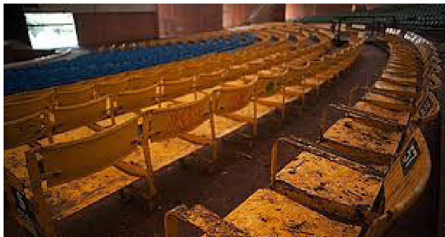
Figura 6 - Interior do Auditório FONTE: Ribeiro (2012)
