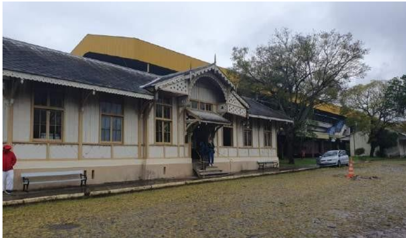
Figura 1 - Fachada da entrada principal do Museu do Trem.
