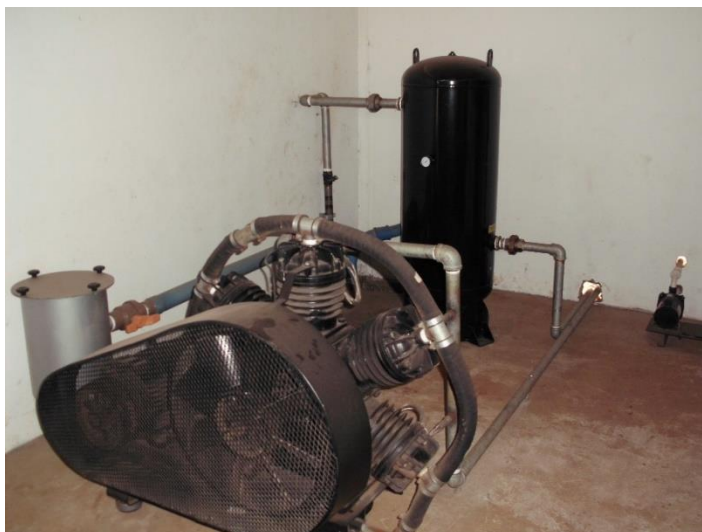
Figura 31 – Sistema de compressão do biogás
