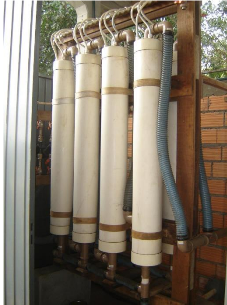
Figura 29 – Sistema de lavagem do biogás da Granja Multiplicadora de Chapecó/SC
