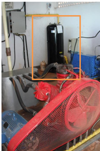
Figura 19 – Compressor de biogás, tanque comprimido e sistema de controle elétrico
