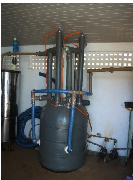
Figura 14 – Sistema de lavagem do biogás da Granja UPL de Palma Sola/SC
