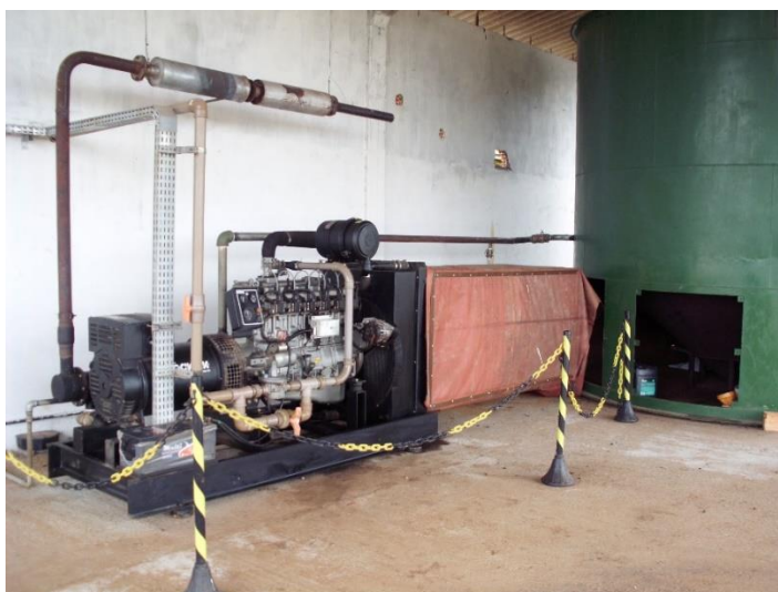
Figura 32 – Gerador a biogás e aquecimento de água utilizando o calor do escapamento do motor e a troca de temperatura do radiador
