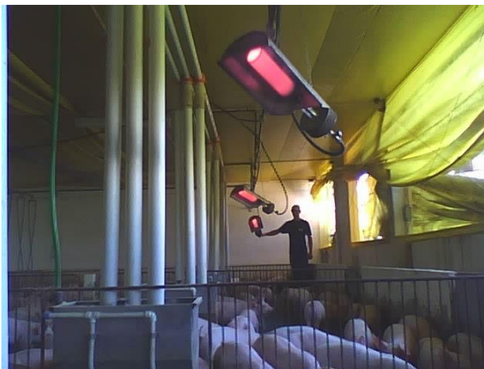
Figura 22 – Campânulas de aquecimento a biogás
