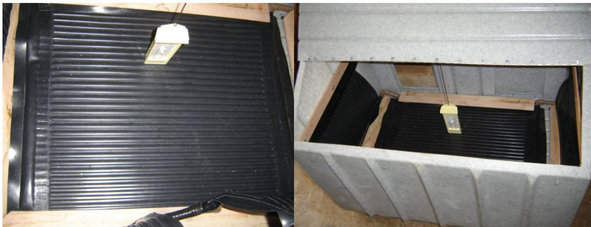
Figura 23 – Placas de aquecimento com água quente para escamoteadores
