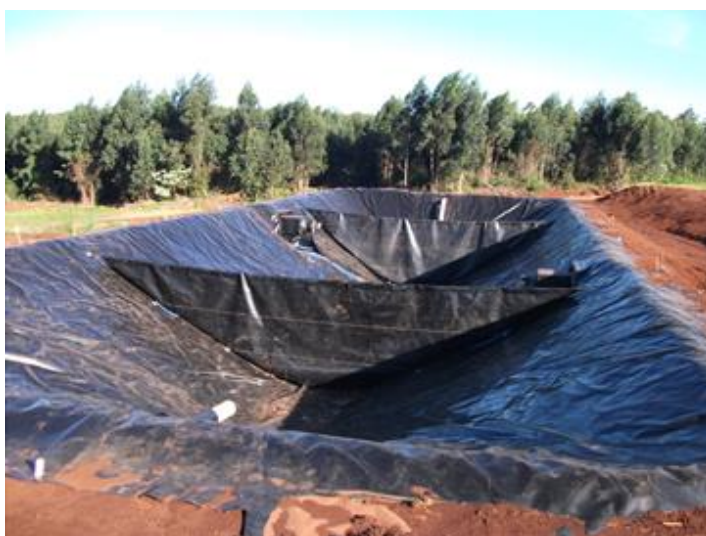
Figura 05 – Modelo híbrido, desenvolvido pela Gter de Chapecó/SC em fase de construção
