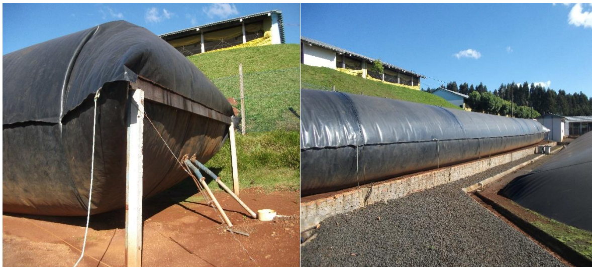
Figura 16 – Balão de armazenamento do biogás após a limpeza
