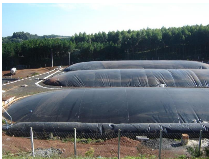
Figura 13 – Biodigestores modelo híbrido desenvolvido pela Empresa Gter de Chapecó/SC
