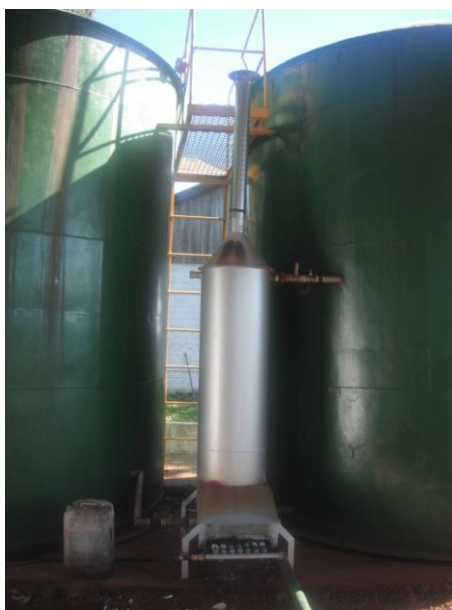
Figura 33 – Boilers de água quente aquecida pelo escapamento do motor do gerador com apoio de queimadores de biogás
