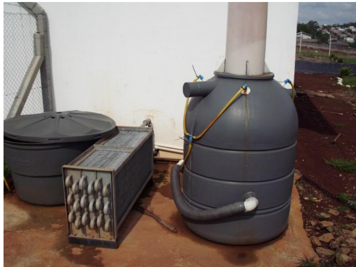
Figura 30 – Sistema de limpeza do biogás da Granja Multiplicadora de Chapecó/SC
