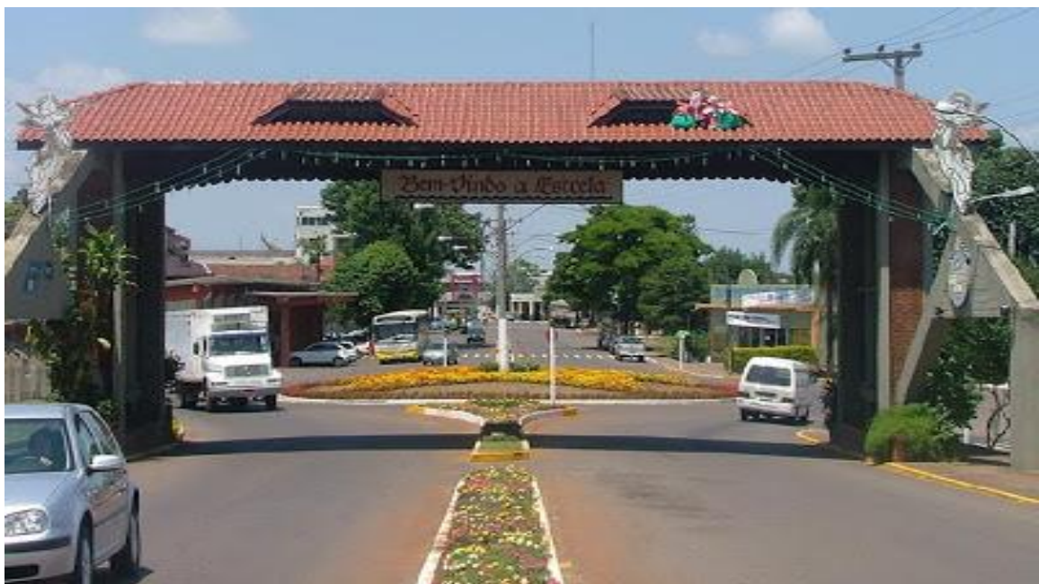
Figura 2 – Pórtico de entrada do município de Estrela
