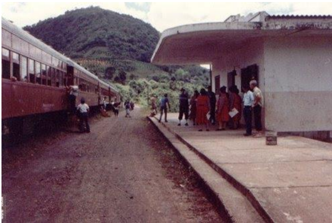
Figura 16 – Estação férrea de São Luiz – Bento Gonçalves - 1970
